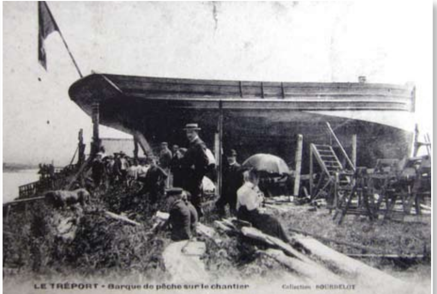
Albert Criquelion sur son chantier
